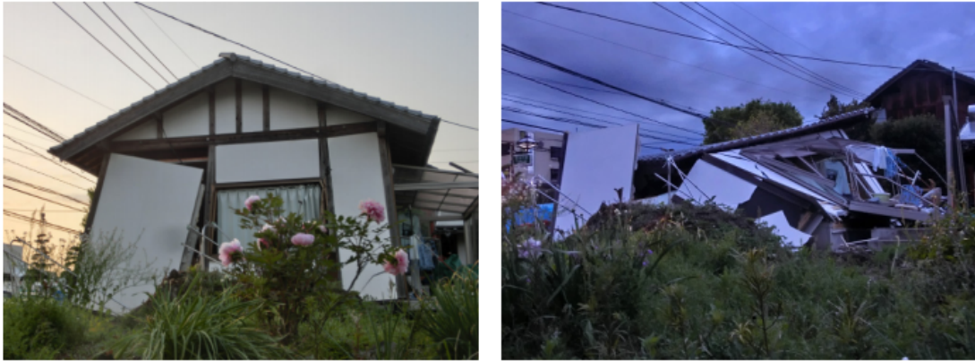
写真 3.3-1 4/15 時点では壁が外れただけの家屋（左）が本震で倒壊（右）した例
