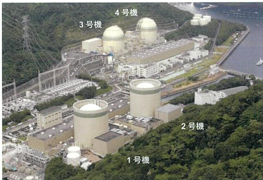
これらのプラント向けに原子炉圧力容器が製造された当時は、まだ内張溶接(クラッド)の施工法が改善途上にあり、アンダー・クラッド亀裂の発生も起こっていた。米国で NRC の前身だった原子力委員会が、その対策のための規制指針(RG 1.43)を発行したのも 1973 年 5 月である。一次冷却系はステンレス鋳鋼(CASS)製で、原子炉容器(RV)～蒸気発生器(SG)間が内径 0.74m、SG～原子炉冷却材ポンプ(RCP)間が内径 0.79m、RCP～RV 間が 0.7m である。
